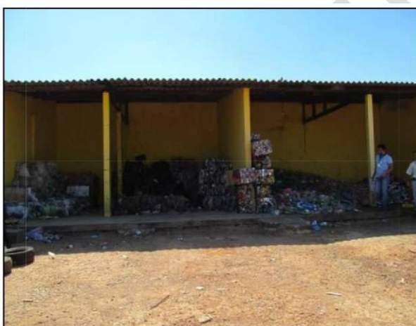
Foto: Exemplo de Centro de Triagem e Compostagem - Depósito de resíduos recicláveis separados.
